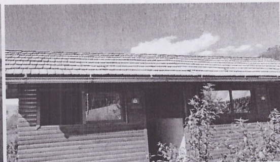
Vista - Baterías Sanitarias
