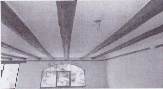
Vista - Cielo Raso Aulas
