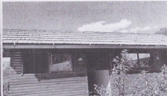
Vista - Baterías Sanitarias
