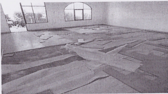
Vista - Piso Aulas
